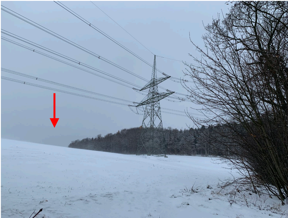
Abb. 11 Flnr. 634/4 , Ansicht der Landwirtschaftsfläche im nordwestlichen Teil mit Stahlgittermast und Hochspannungsfreileitung
