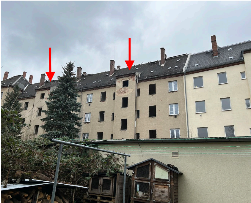
Abb. 04 Teilansicht Gebäuderückseite mit Dachausbildung, Westen
