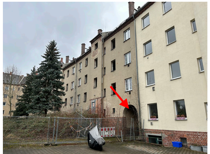
Abb. 03 Teilansicht Gebäuderückseite und Gebäudedurchfahrt, Westen
