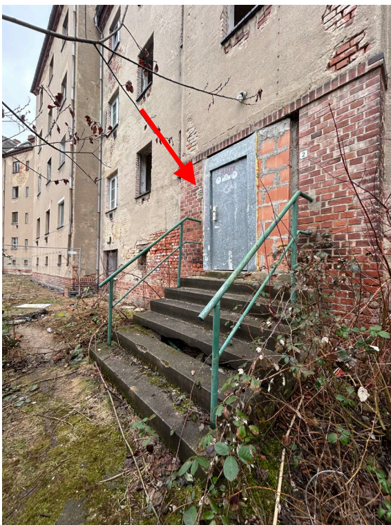
Abb. 05 Teilansicht Gebäuderückseite und Eingang zum Gebäudeteil Wartburgstraße 2
