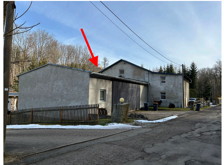
Abb. 02 Ansicht des Gebäudes von Westen und angebautes Lagergebäude
