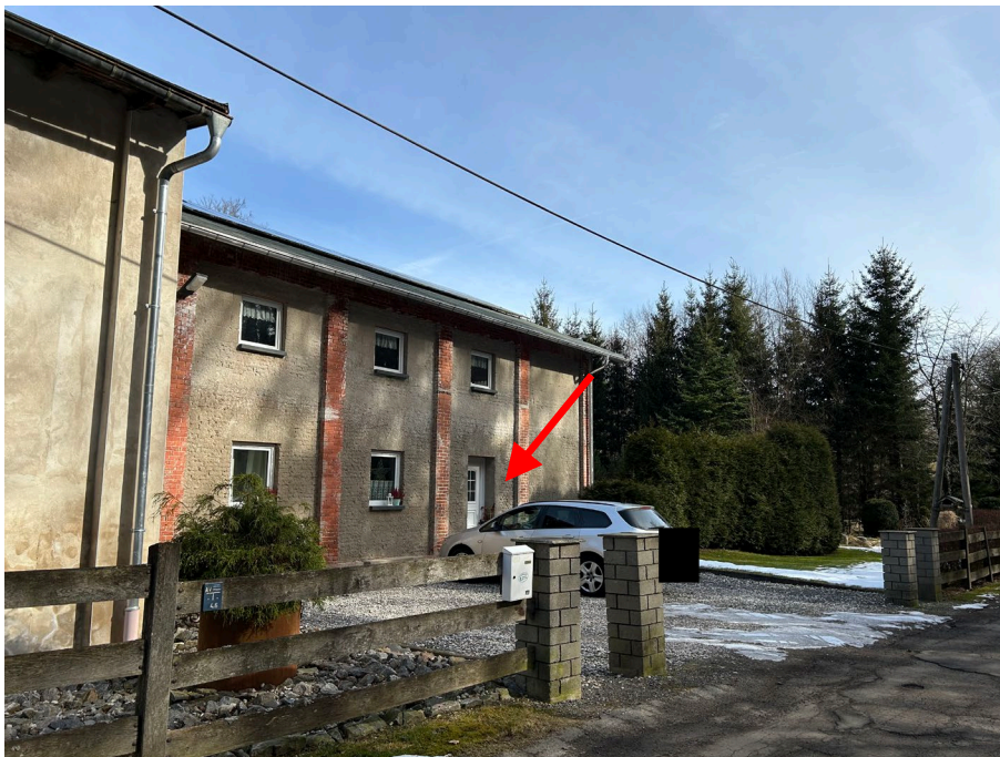
Abb. 04 Teilansicht des Gebäudes und Lage von Eingang zu Wohnung Nr. 2
