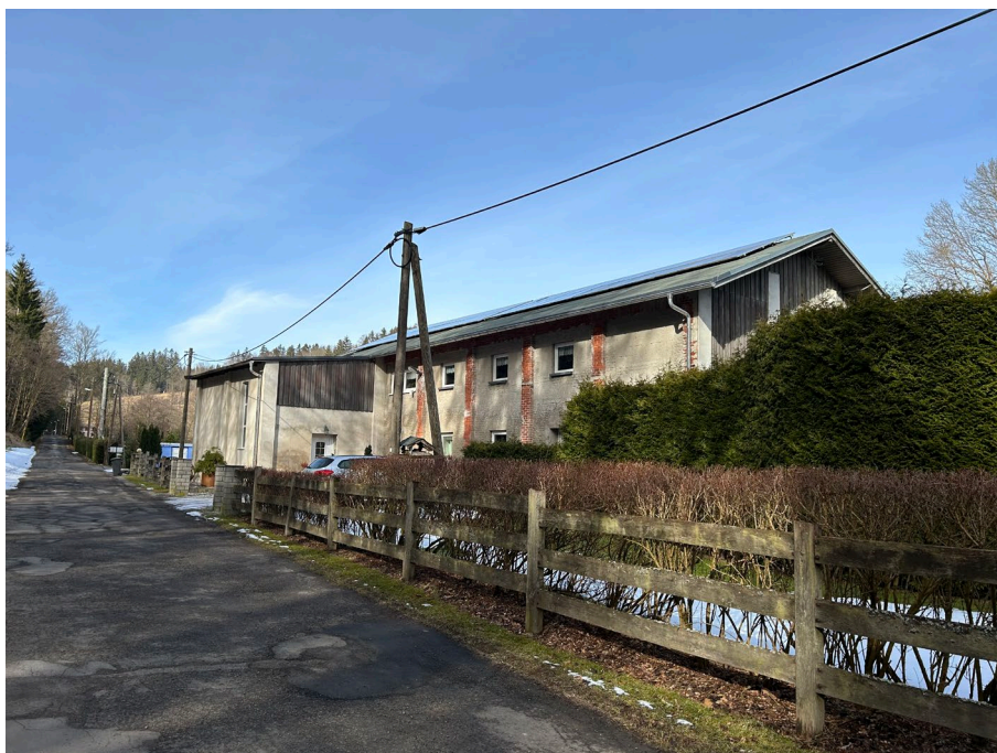
Abb. 09 Teilansicht Gesamtanlage und Rungstockstraße, Blick in Richtung Westen
