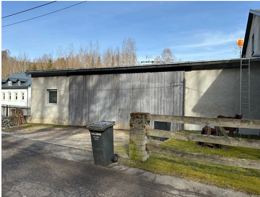
Abb. 05 Vorderansicht Lagergebäude, Süden
