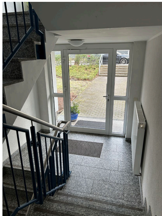
Abb. 07 Teilansicht Treppenhaus im Gebäude Haus Nr. 37, Blick zur Hauseingangstür
