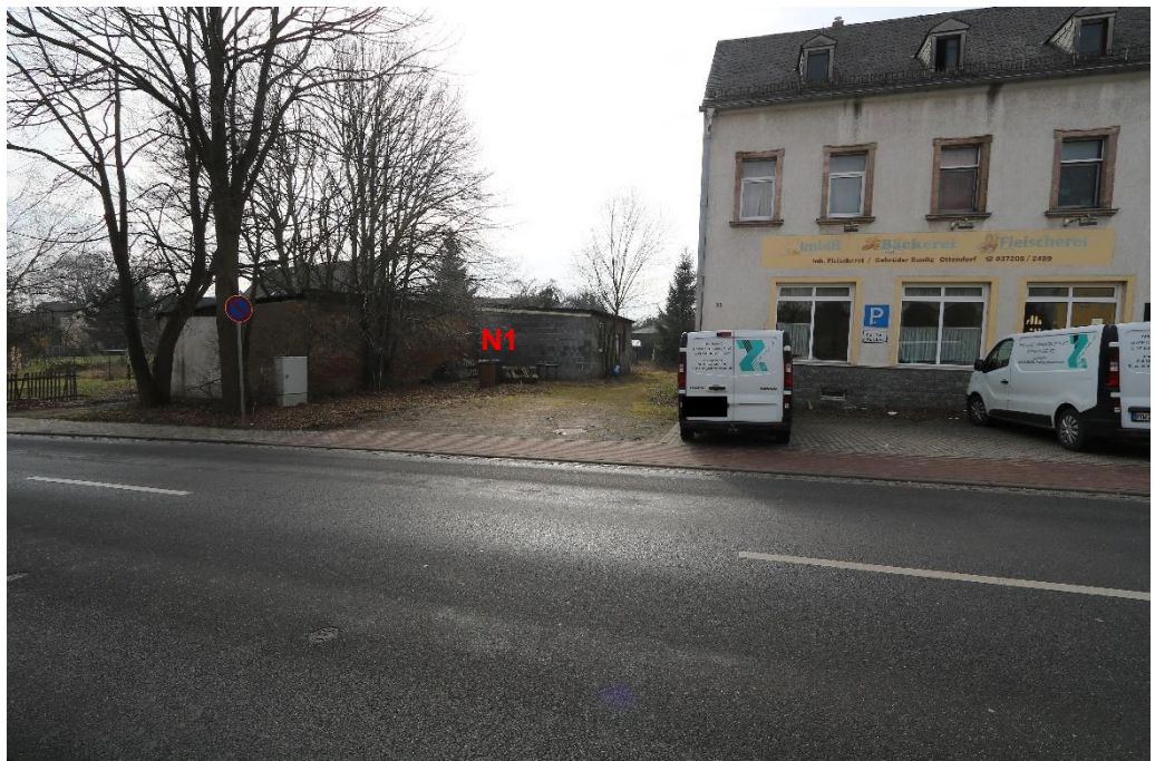
Blick zum Nebengebäude N1
