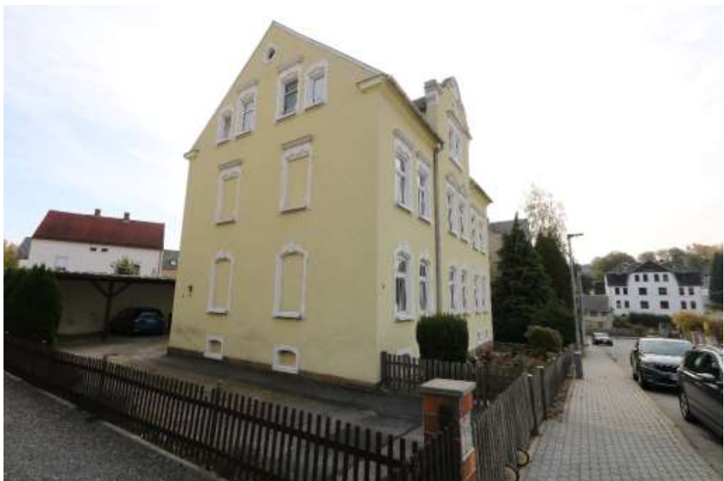
Richard-Meinig-Straße nach Süd mit Grundstückseinfahrt und Vorgarten
