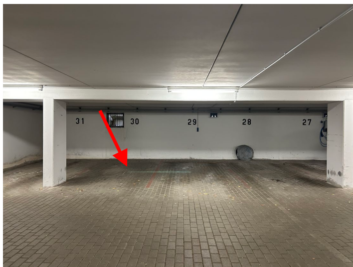
Abb. 06 Teilansicht Tiefgarage und Ansicht von Stellplatz Nr. 30
