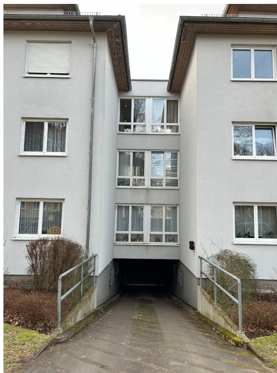
Abb. 02 Ansicht Tiefgaragenzufahrt mittig zwischen den Gebäuden
