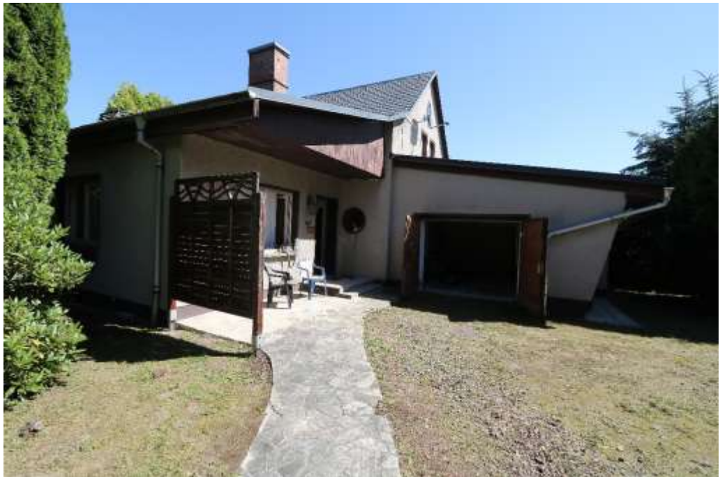
SW-Ansicht mit Hauseingang und Garage
