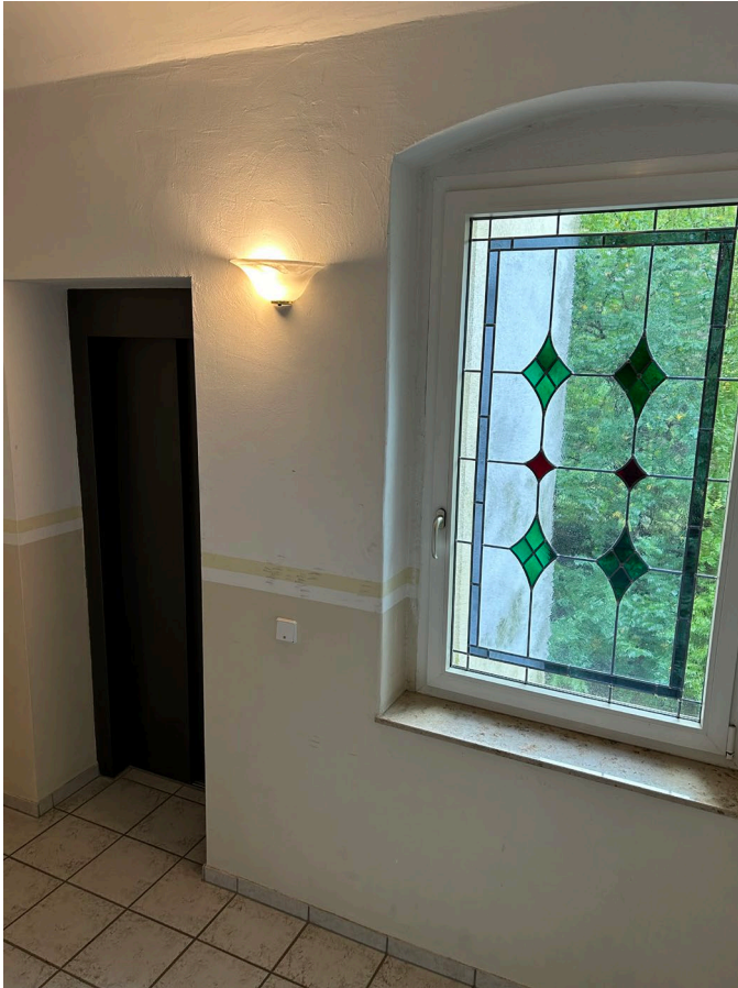
Abb. 08 Teilansicht Treppenhaus Zwischenpodest mit Aufzug
