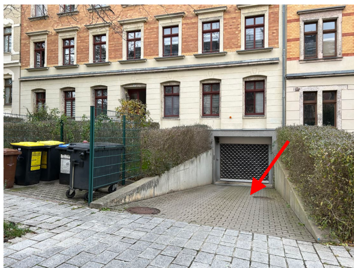
Abb. 02 Ansicht Zufahrt zur Tiefgarage im Haus Tannenstr. 6
