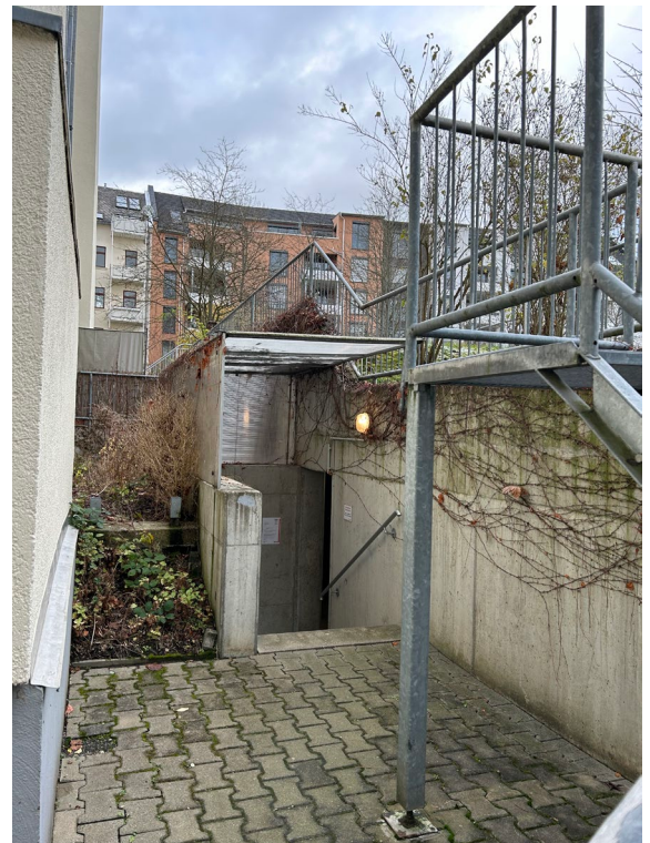
Abb. 10 Zugang zur Tiefgarage über Haus Tannenstraße 4 und Teilansicht Metalltreppe auf die Dachfläche der Tiefgarage
