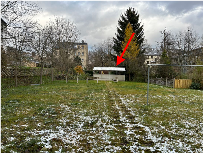
Abb. 04 Teilansicht Dach Tiefgarage mit TG-Ausgang, Grundstücksbereich Tannenstraße 6
