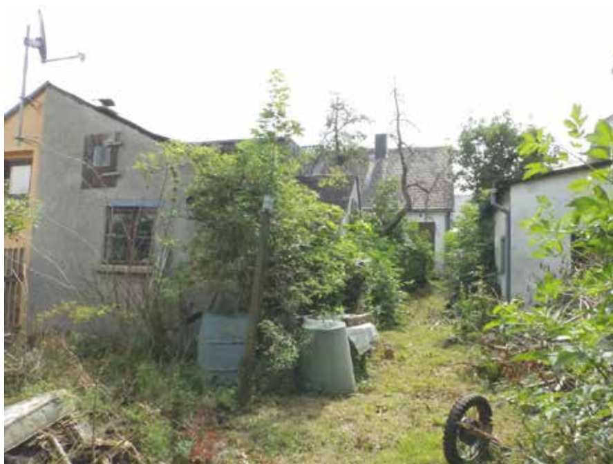
Bild 2: Blick auf die Gebäude vom Garten aus
