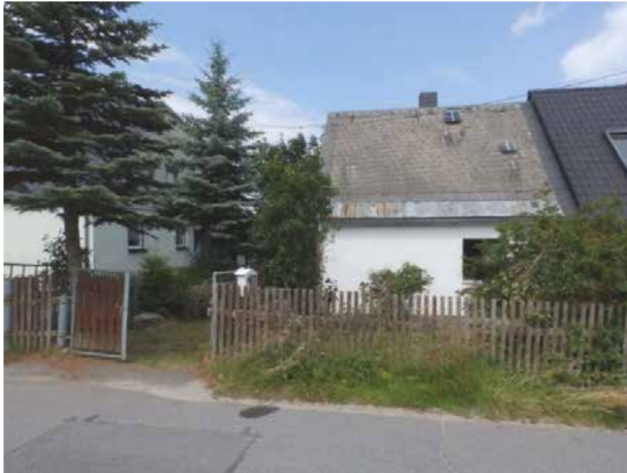
Bild 1: Straßenansicht des Bewertungsobjekts
