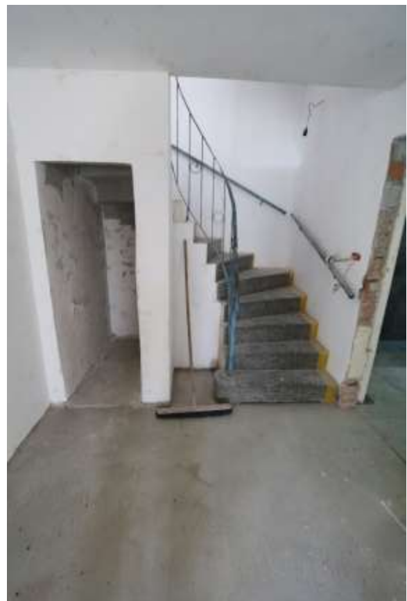
EG- Flur mit Geschosstreppe
