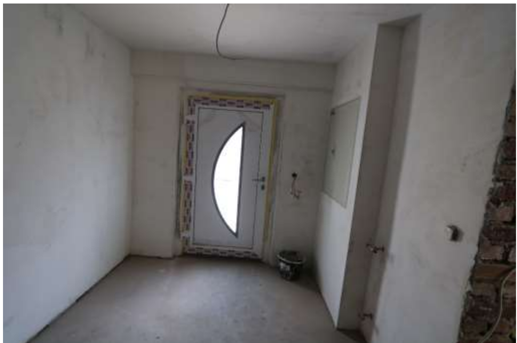
EG-Flur mit Haustür
