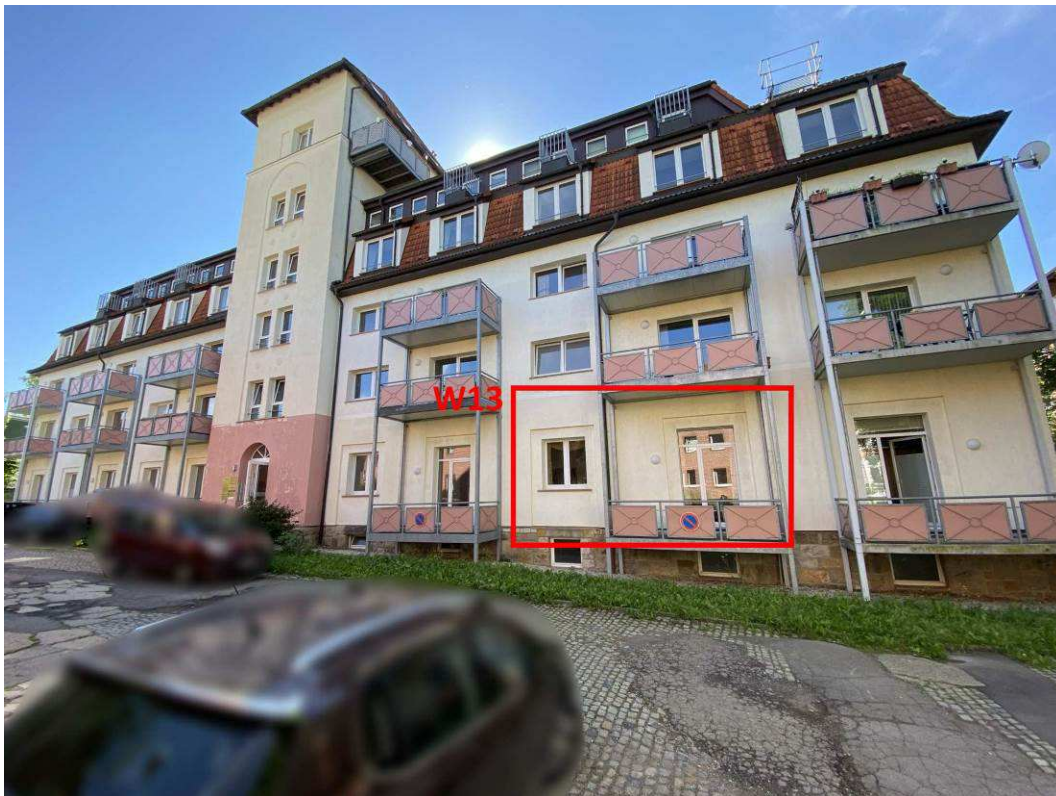
Gebäuderückseite (Blick aus westlicher Richtung)
