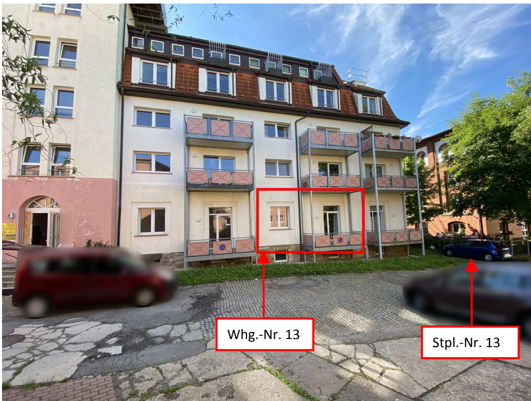
Westfassade des Gebäudes; nach Aufteilungsplan liegt der Stpl.-Nr. 13 an der markierten Stelle
