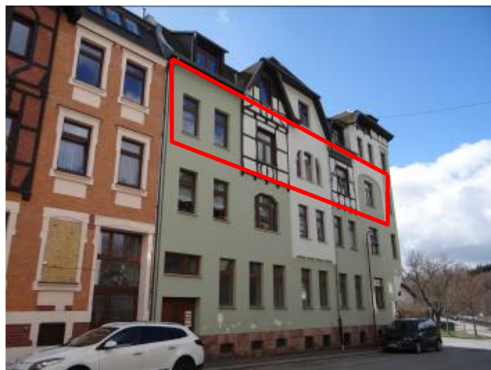
Abb. 02 Ansicht des Wohn- und Geschäftshauses von der Talstraße aus und Lage der Räume Nr. 3 im 2.OG, Norden
