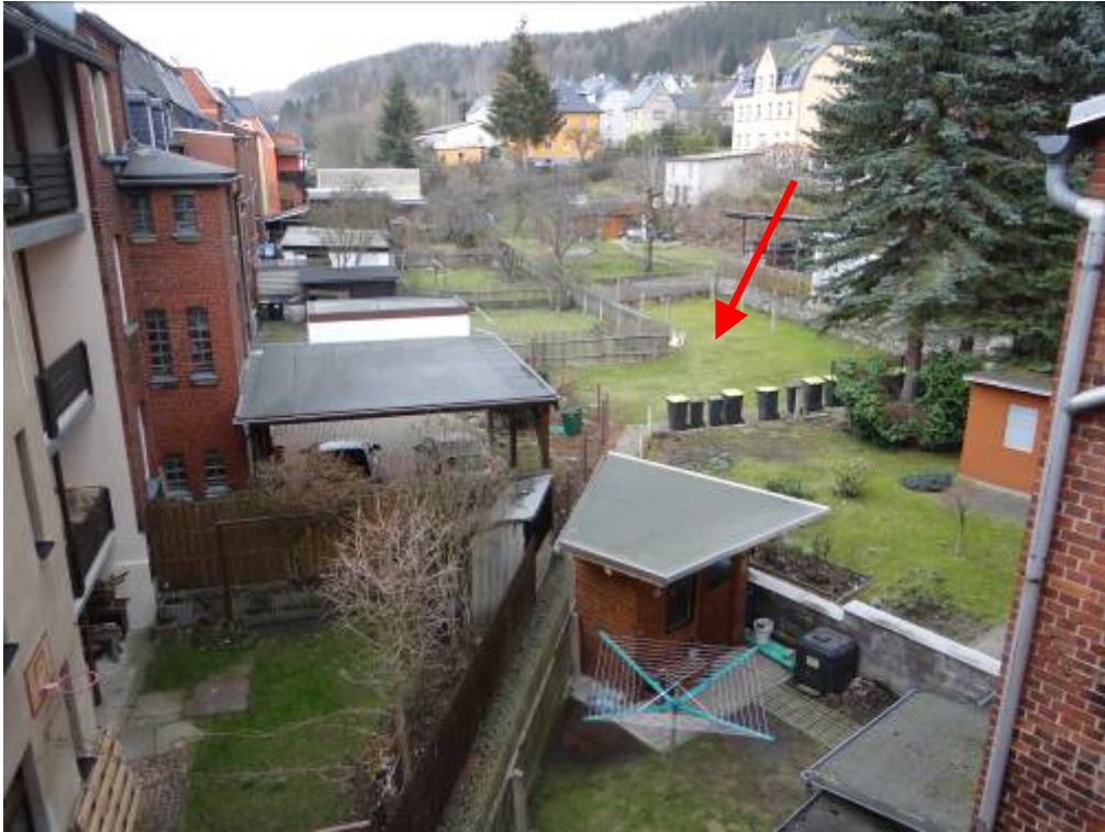
Abb. 03 Teilansicht der rückwärtigen Grundstücksfläche mit Zugangsweg
