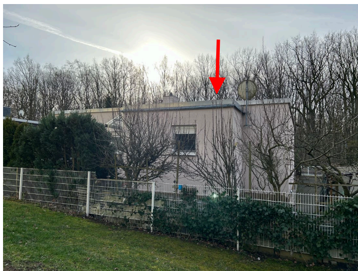
Abb. 06 Teilansicht Gebäuderückseite mit Vorhausanbau, Norden
