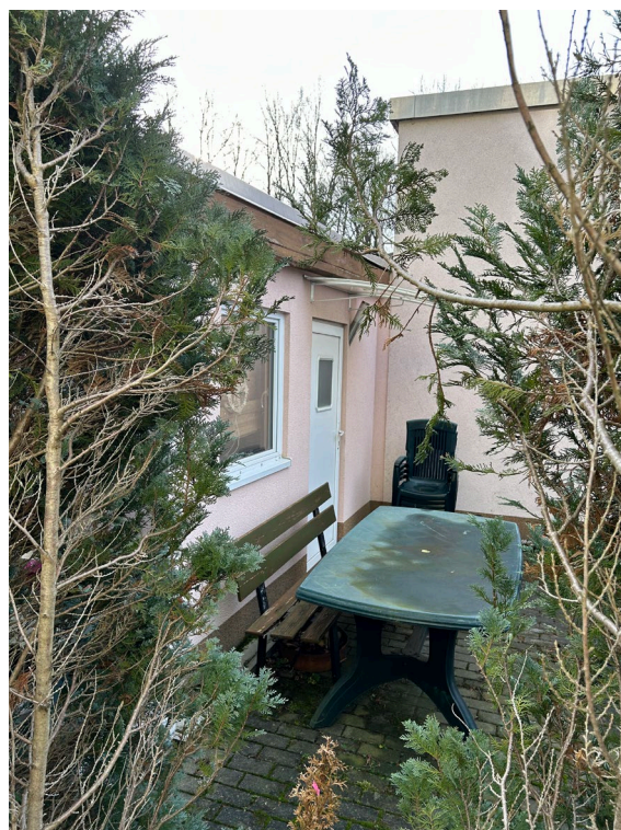
Abb. 07 Teilansicht Anbau Garage auf Garagenrückseite
