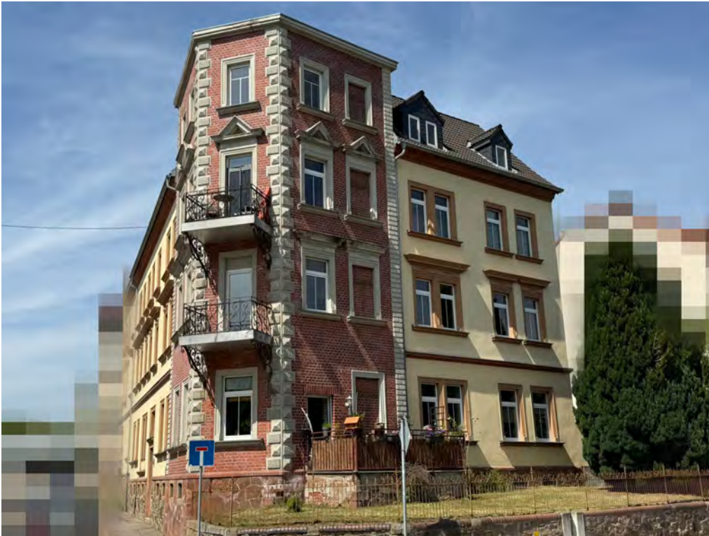
Blick von der Thierbacher Straße aus südlicher Richtung
