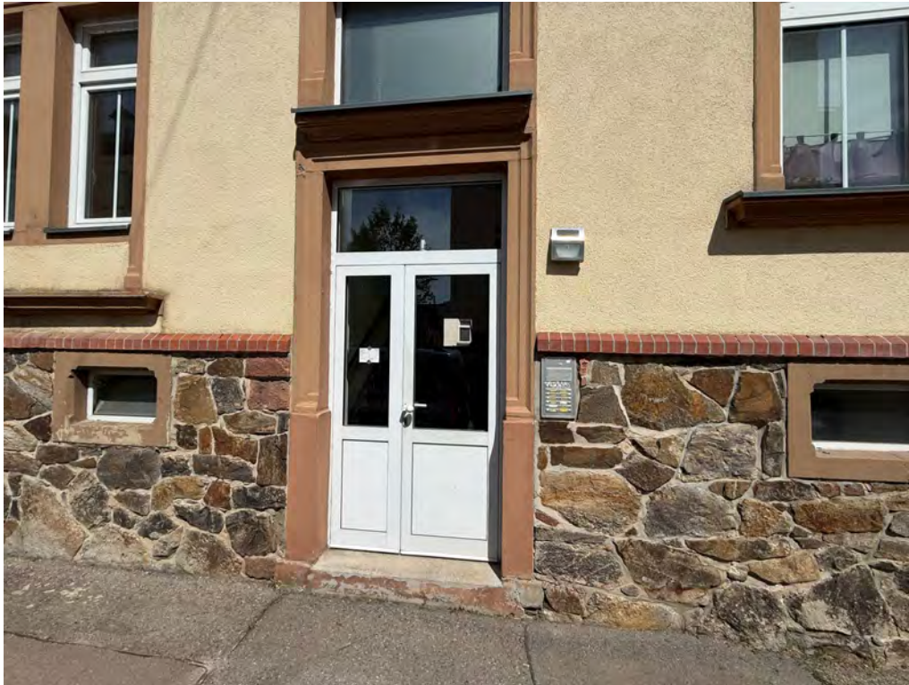
Hauseingangstür an der Schillerstraße
