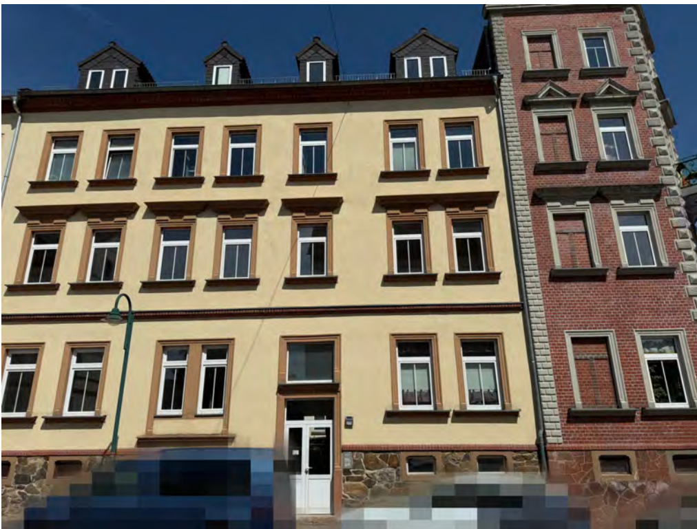
Fassade an der Schillerstraße
