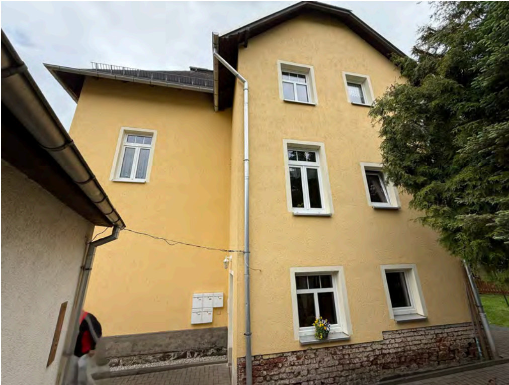
Rückseite des Wohnhauses
