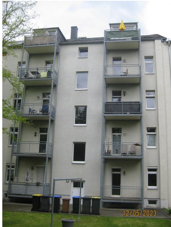
Blick hofseitig auf Wohnanlage Ulbrichtstraße 11
