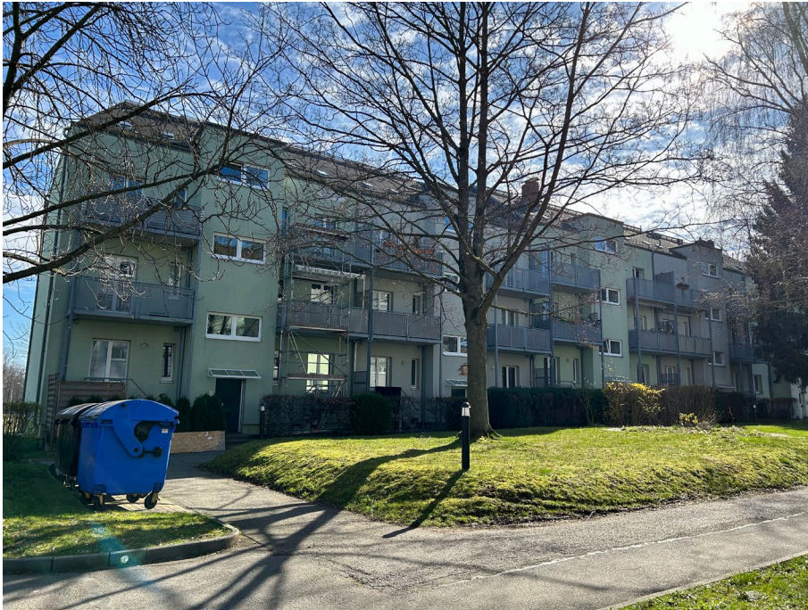
Abb. 03 Ansicht Gebäuderückseite Haus Nr. 64, 66, 68, 70, Westen
