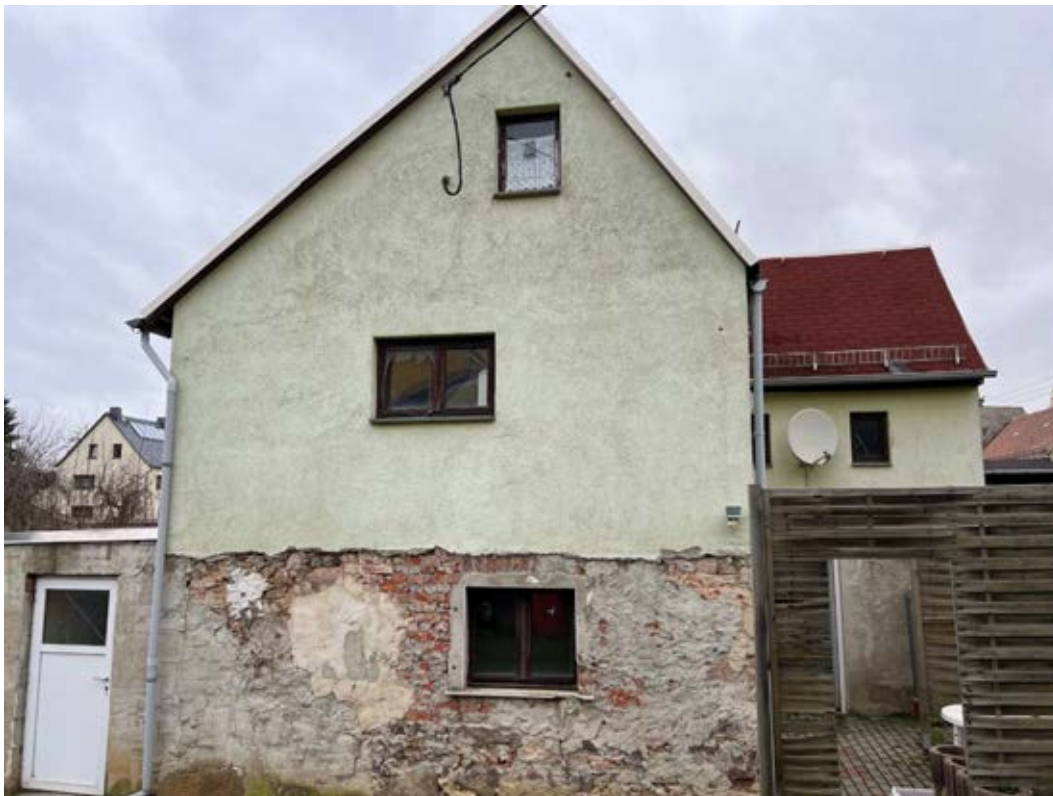
Südgiebel des Wohnhauses
