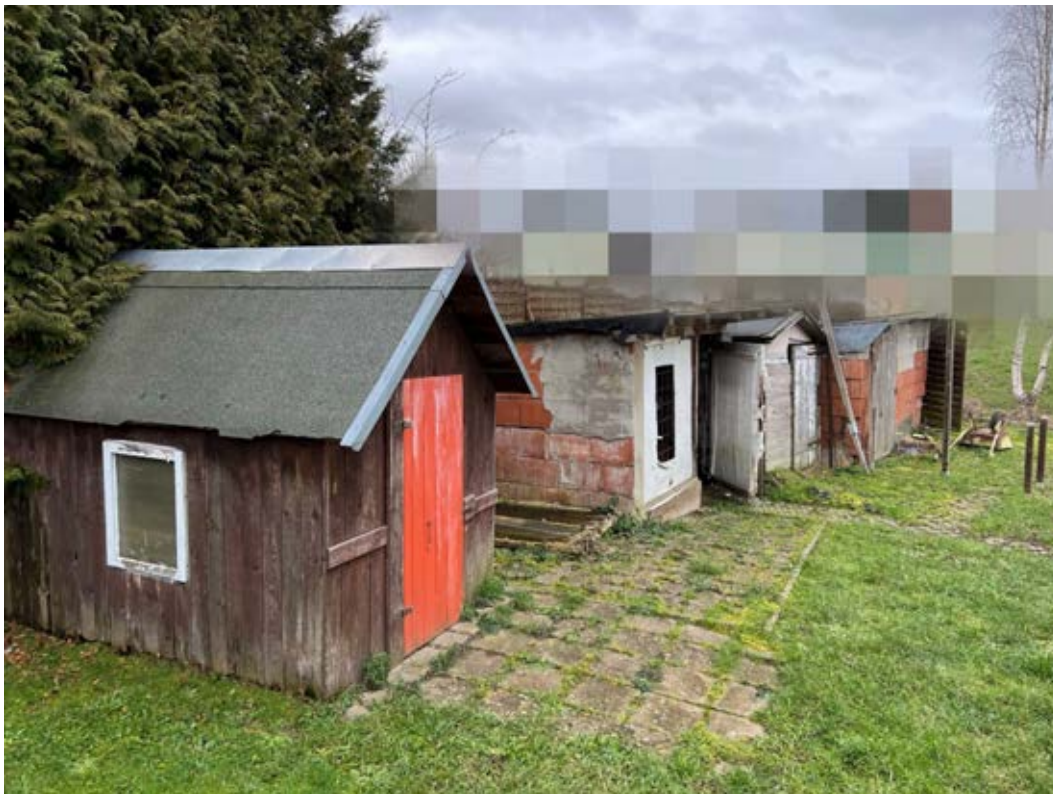
Nebengebäude entlang der südlichen Grundstücksgrenze
