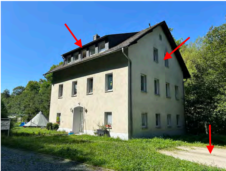
Abb. 01 Vorderansicht des Wohngebäudes mit Hauseingang, Osten, Ansicht nördliche Giebelseite, Teilansicht befestigte Stellplatzfläche und Lage der Wohnung WE 4 im Dachgeschoss
