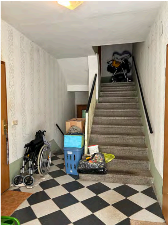
Abb. 05 Teilansicht Hausflur im Erdgeschoss und Treppenanlage zum Obergeschoss
