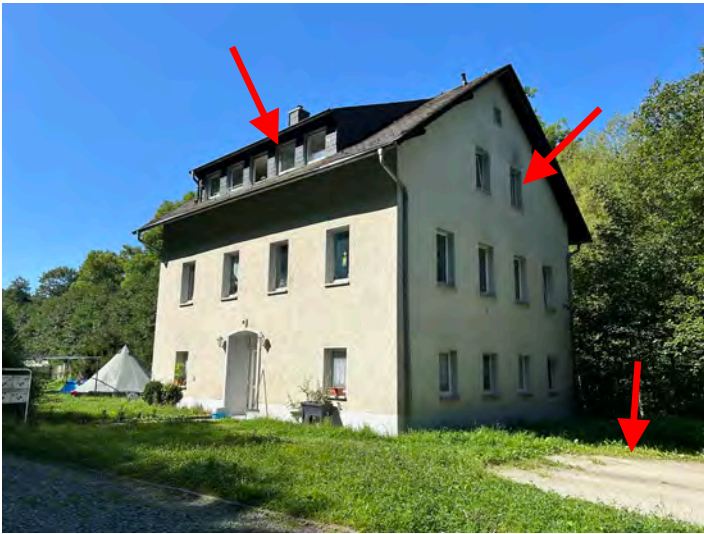
Abb. 01 Vorderansicht des Wohngebäudes mit Hauseingang, Osten, Ansicht nördliche Giebelseite, Teilansicht befestigte Stellplatzfläche und Lage der Wohnung WE 4 im DG
