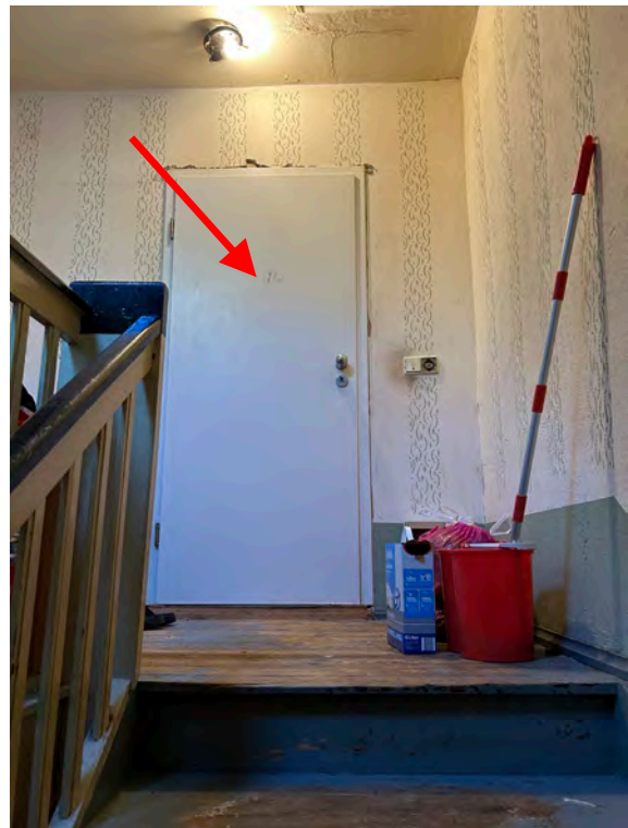
Abb. 06 Teilansicht Treppenhaus im Dachgeschoss und Ansicht der Eingangstür zu Wohnung WE 4
