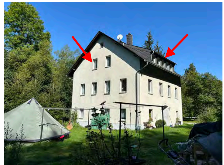
Abb. 02 Ansicht Wohngebäude von Süden und Lage der WE 4 im DG
