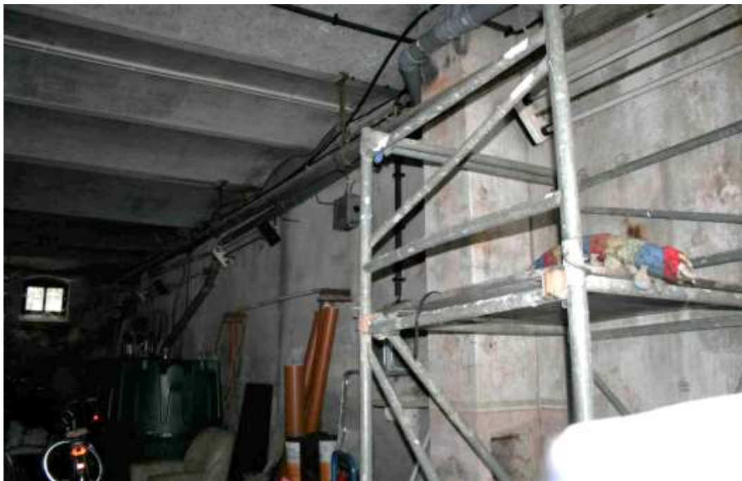
Innenansicht Anbau EG
