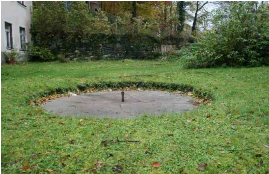
Vorgarten mit denkmalgeschützter ehem. Brunnenanlage
