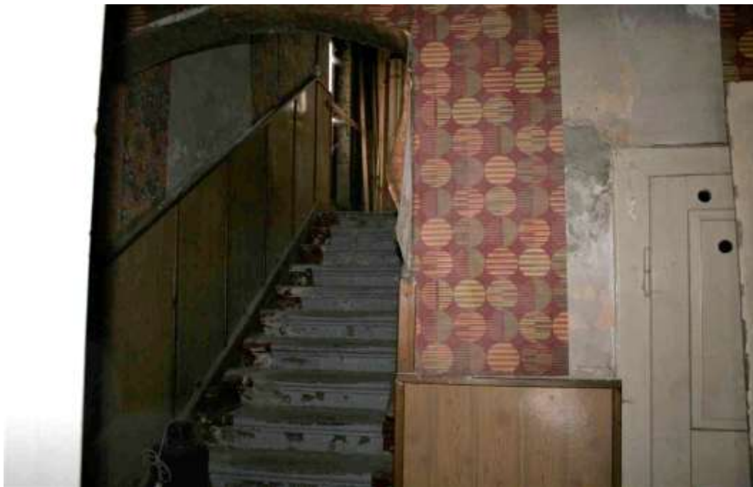
Innenansicht MFH Treppenhaus EG
