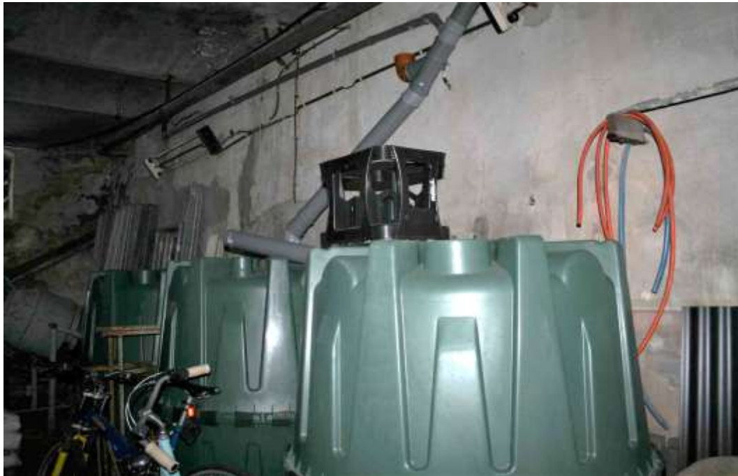
Innenansicht Anbau EG Kläranlage
