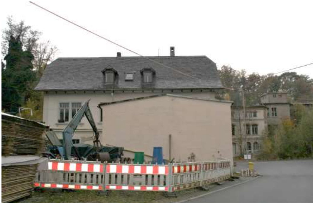
Ostansicht Villa mit Anbau davor
