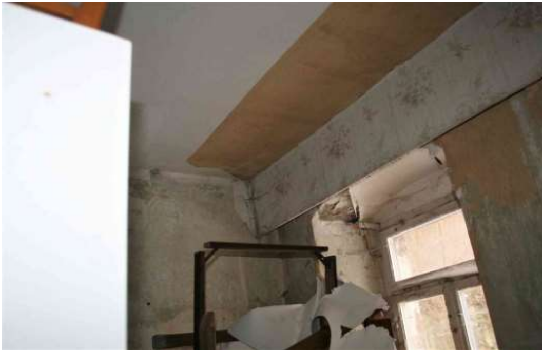
Innenansicht MFH OG
