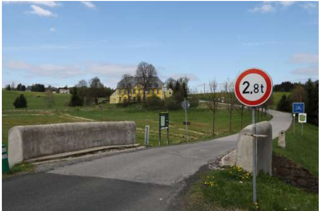
Südansicht von der Einsiedler Straße
