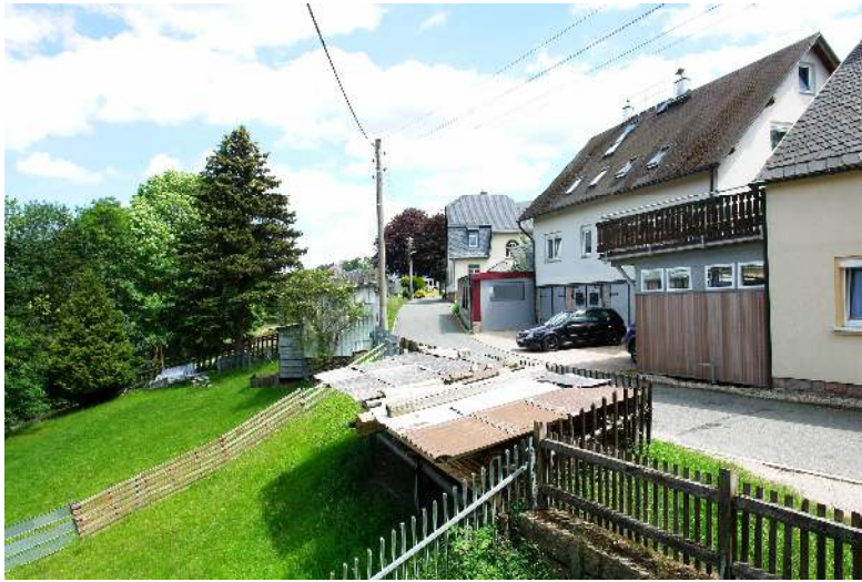
Bild 10: Mittelstraße östlich; Siedlungsbebauung, Nachbarn unbebaut
