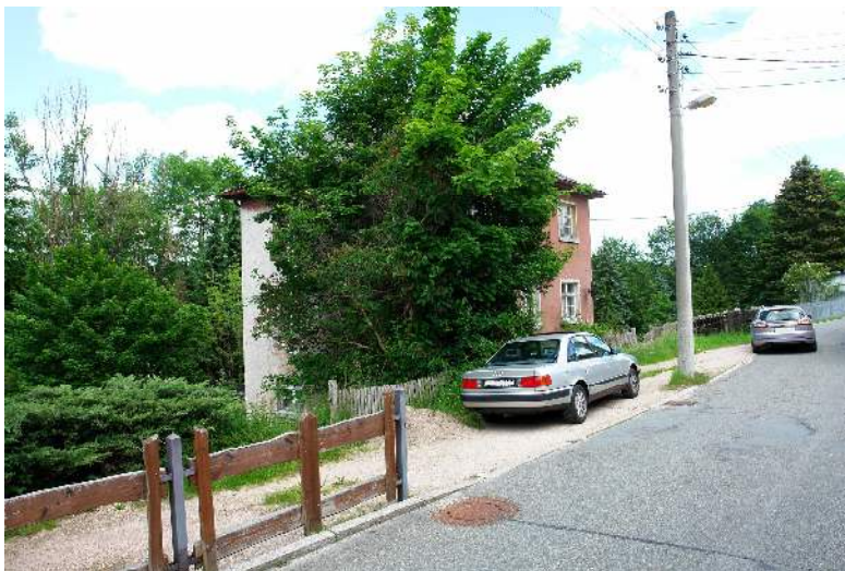
Bild 3: Ansicht straßenseitig (West) Der Grundstückstreifen zwischen Zaun und Straße gehört zum Grundstück
