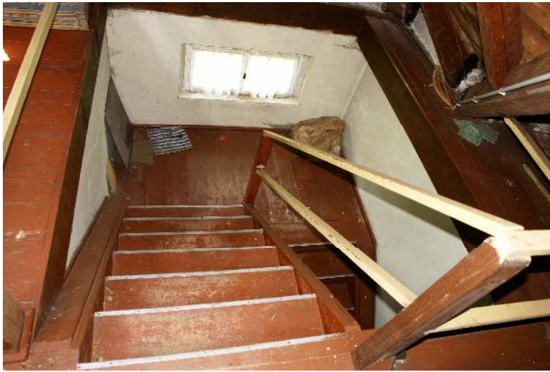
Bild 40: Treppenlauf OG - Dachraum
