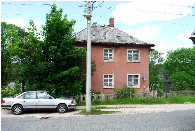
Bild 2: Ansicht Wohnhaus straßenseitig (Süd)
