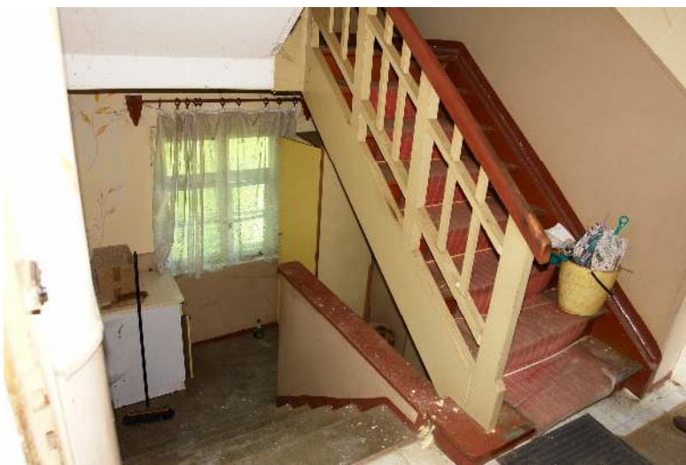
Bild 30: Treppenhaus 1. KG – EG - OG
