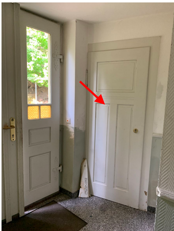
Abb. 08 Ansicht der Lage von Abstellraum Nr. 2 im Zwischengeschoss/ Hauseingangsebene
