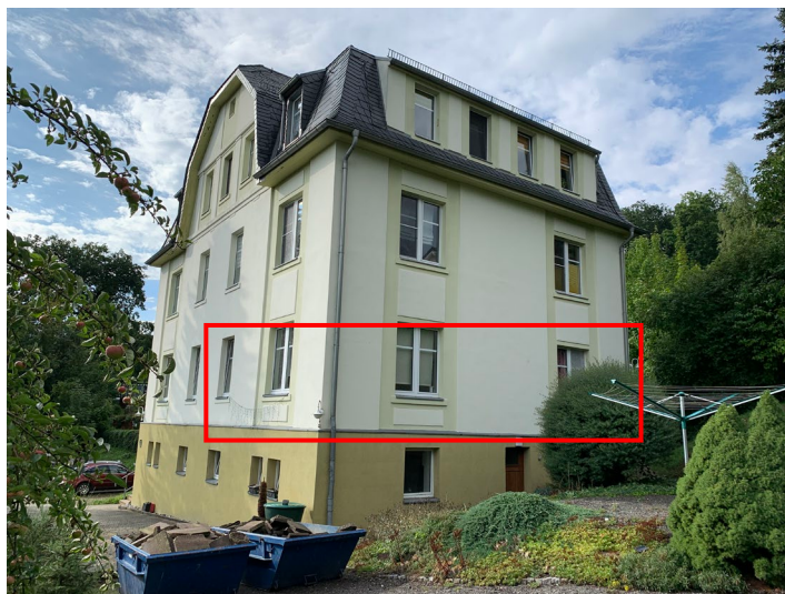
Abb. 02 Ansicht des Gebäudes von Osten und Lage der Wohnung WE 2 im Erdgeschoss
