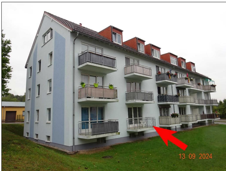
Rückansicht Mehrfamilienhaus mit Balkonen
