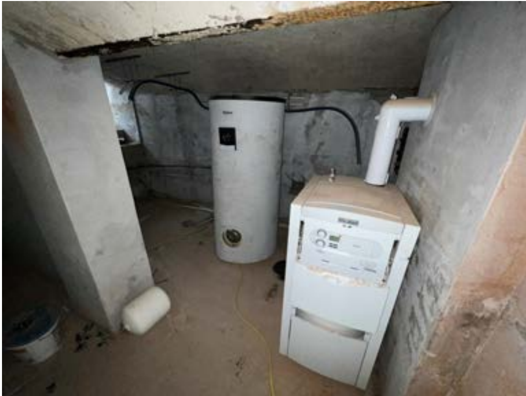
aufgestellte Gasheizanlage nebst Warmwasserspeicher im Kellergeschoss
