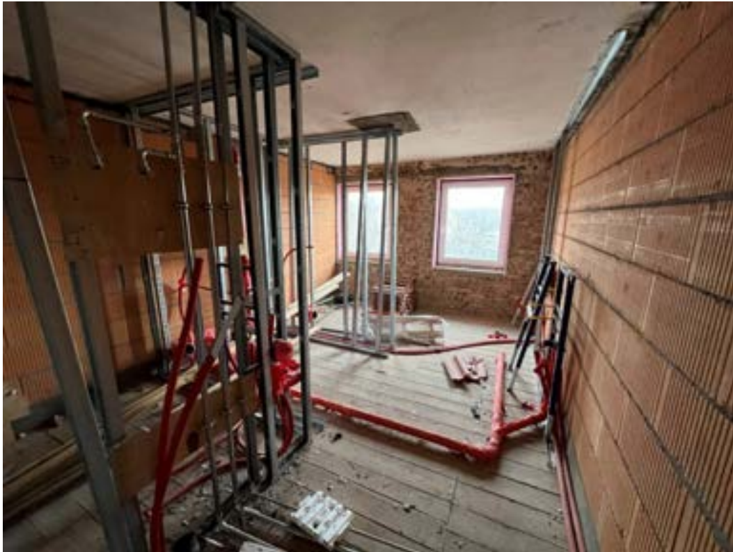
begonnene Sanitärinstallation und Trockenbau
