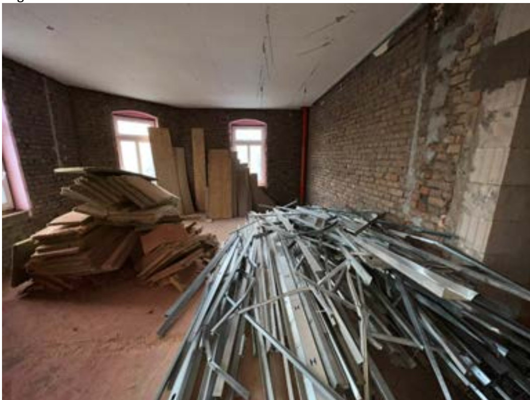
ausgebaute Trägerkonstruktion der Unterhangdecke und alte Dämmmatten
