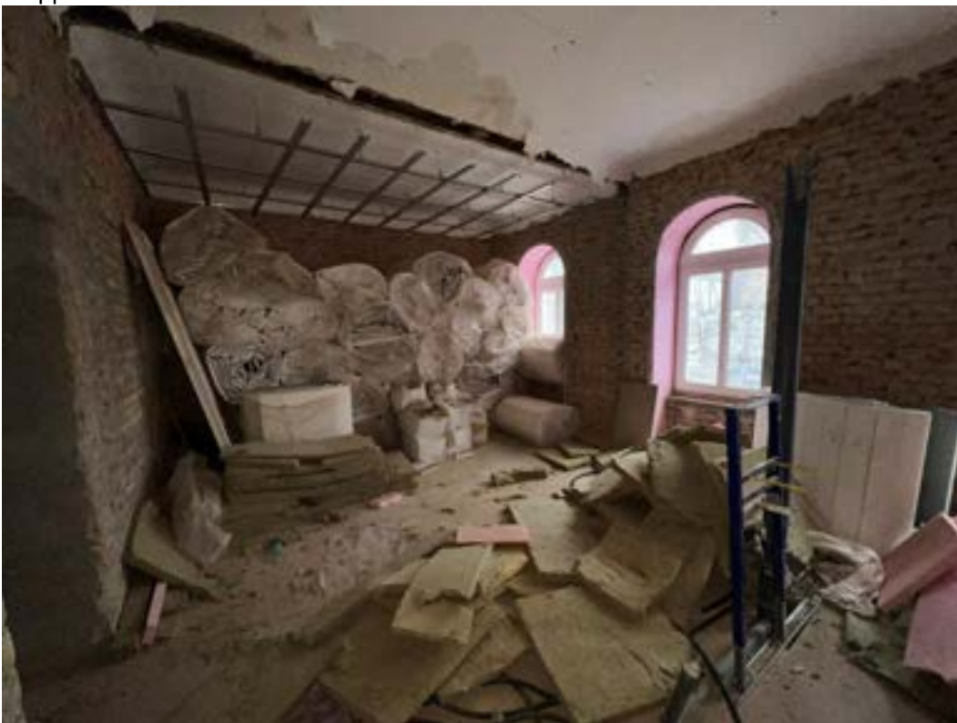
Raum im EG; hinten zu sehen sind die Wärme-Trittschall-Dämmrollen (vgl. Pkt. 9)
