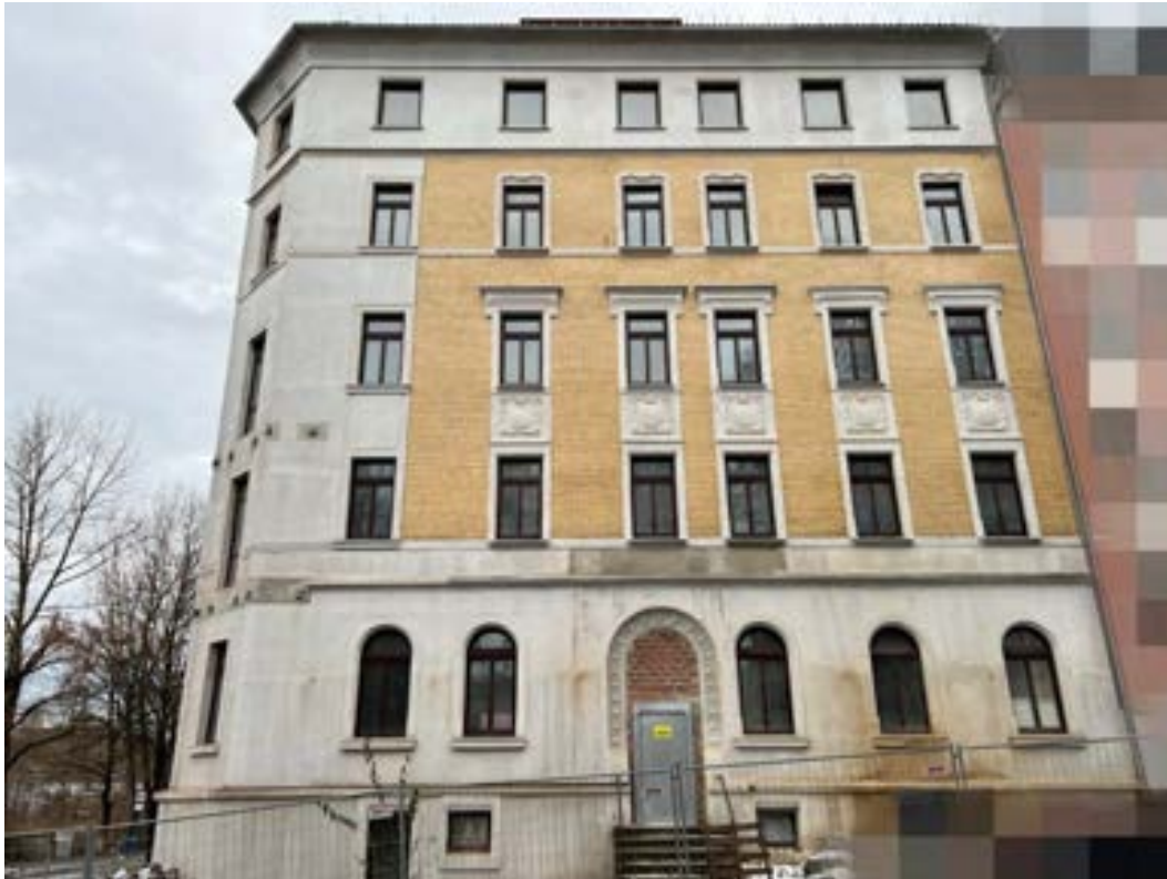
Fassade zur Wattstraße
