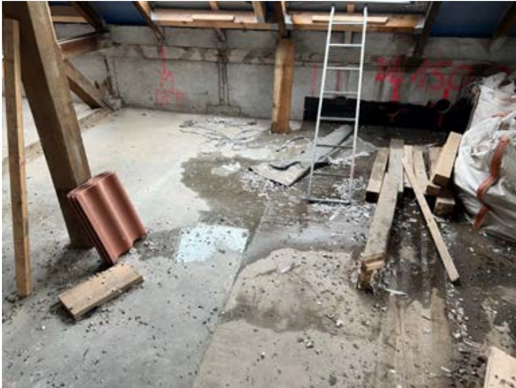
Eindringendes Niederschlagswasser im DG wegen nicht fertig gestellter Dacheindeckung
