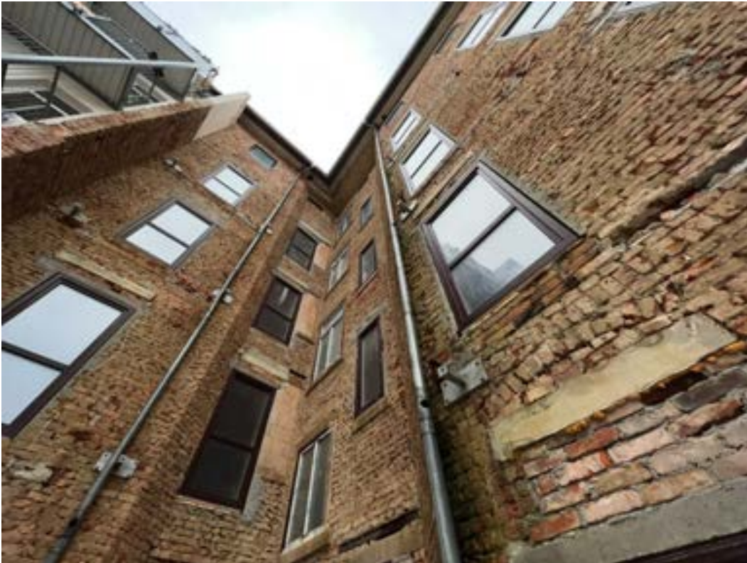
Hoffassade (oberer Teil)
