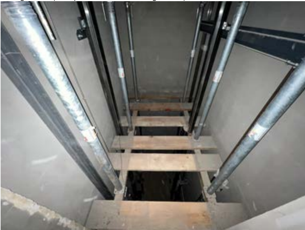
nicht fertig gestellter Aufzugsschacht im Obergeschoss
