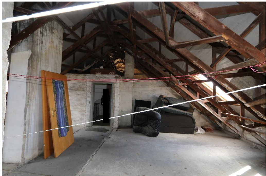
Reitbahnstraße 53, Dachgeschoss, rechts
