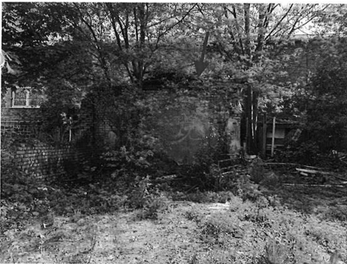
Abb. 05 Teilansicht des Nebengebäudes und Aufwuchs sowie der Rückwand des nahe gelegenen Gewerbegebäudes auf Flnr. 999/2
