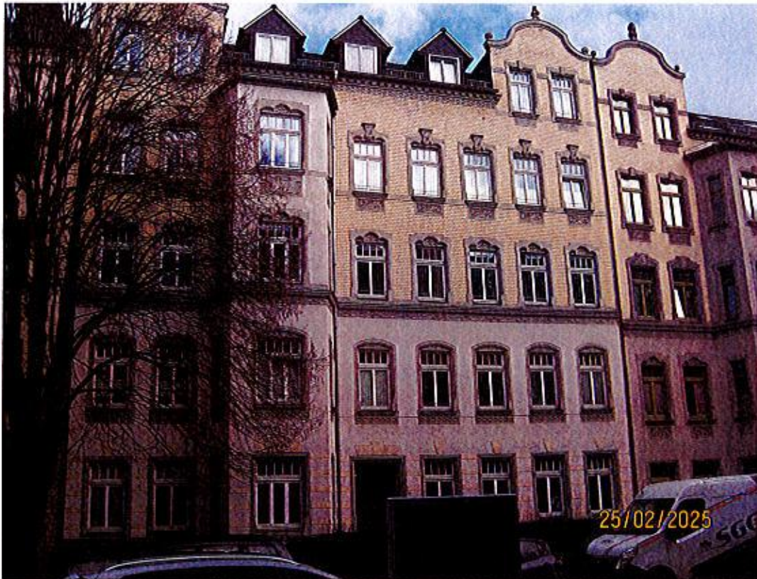
Blick auf die Wohnanlage von Theodor-Lessing-Straße aus gesehen
