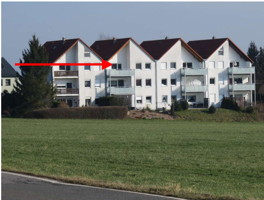
Bild 2: Ansicht von Südwesten
