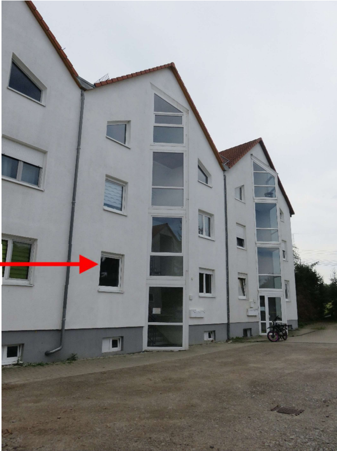
Bild 1: Ansicht von Nordosten
