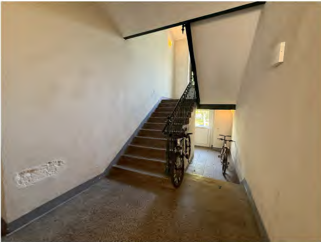
Treppenhaus im Erdgeschoss
