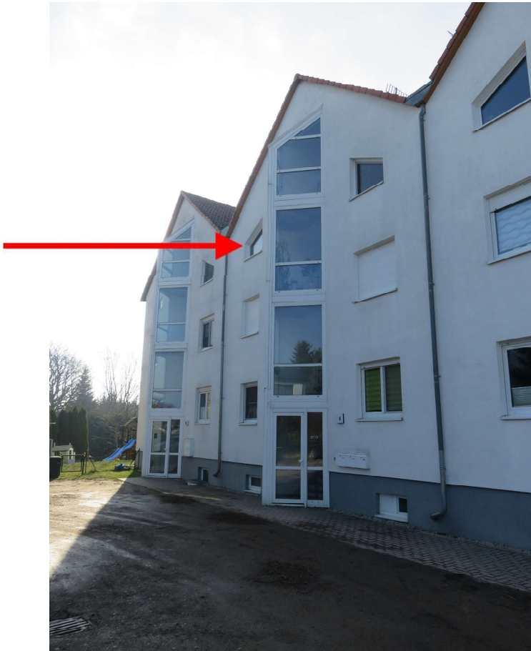
Bild 1: Ansicht von Nordosten
