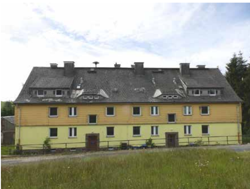
Bild 2: Straßenansicht des Mehrfamilienhauses
