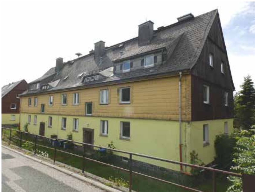
Bild 3: Straßenansicht des Mehrfamilienhauses
