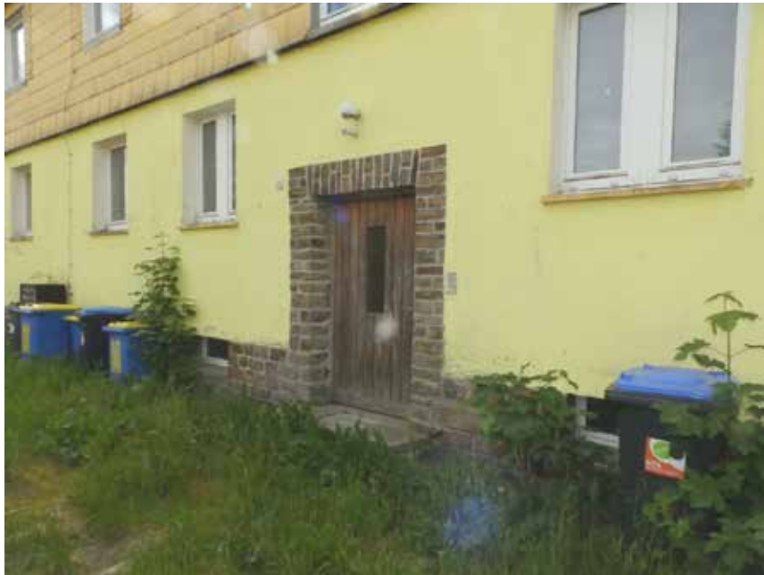
Bild 7: rechter Hauseingang des Mehrfamilienhauses
