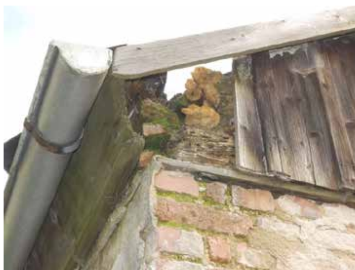
Bild 14: Details der Dachkonstruktion des Wirtschaftsschuppens (Seite zu Bewertungsobjekt gehörend)
