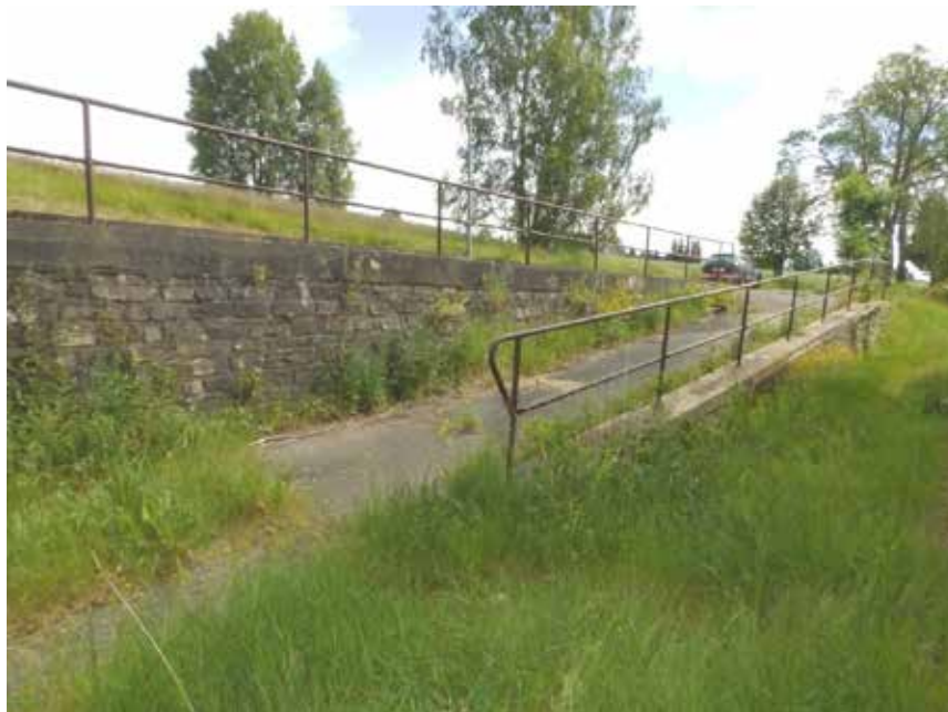
Bild 19: Rampe zur Straße
