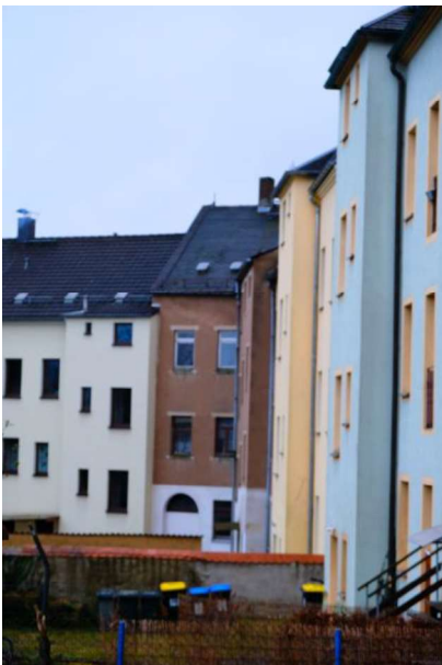
Hof- bzw. Nord-West-Ansicht des WGH, z. T. unsanierte Fassade, Satteldach, zum Hof kleine Gauben
