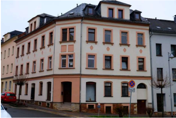
Straßen- bzw. Südansicht des WGH, Eckhaus, bestehend aus KG, EG, 1. und 2. OG, vermutlich ausgebautes DG, ursprüngliches Baujahr um 1889, erste kleine Instandsetzungen nach 1990
