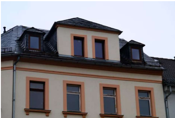
Schiefereindeckung, Dach mit Walmgauen
