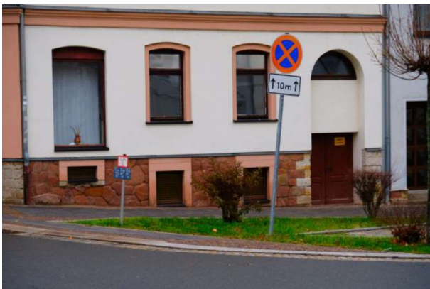
Keller- und Sockelbereich Naturstein, sep. Keller- ausgang, Putzfassade
