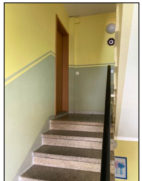
Treppenhaus mit WET zu WE Nr.11
