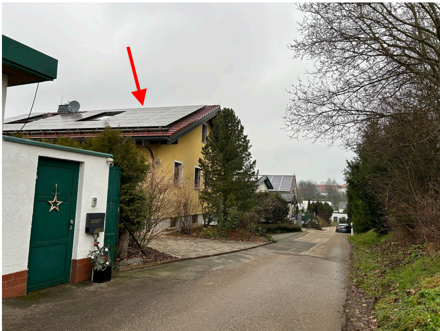
Abb. 02 Teilansicht des Gebäudes von Süden mit auf dem Dach vorhandener PV-Anlage sowie Teilansicht Frankenberger Straße im Bereich Bewertungsobjekt
