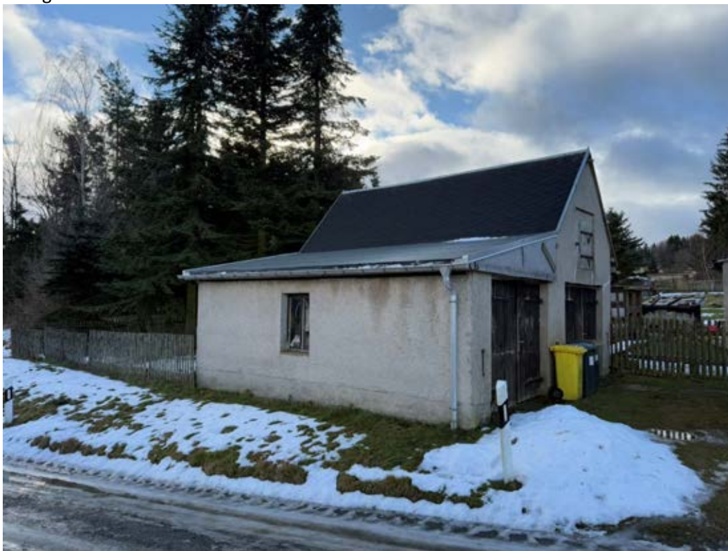
Blick auf die Garage mit Werkstattanbau aus nördlicher Richtung
