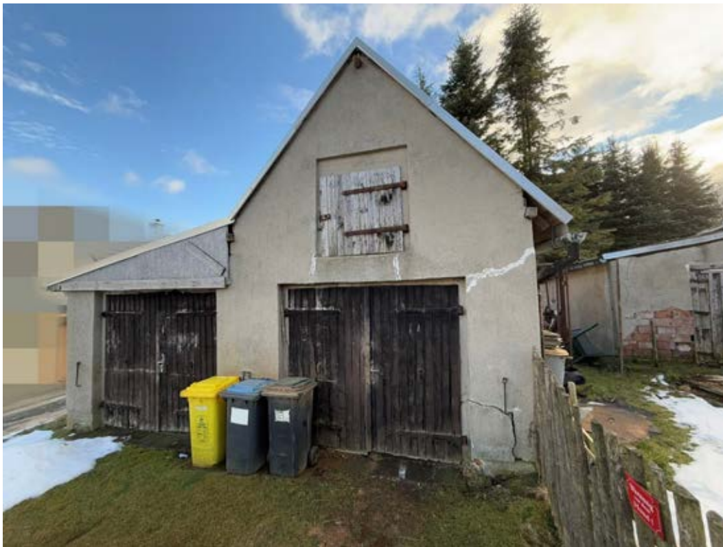
Garage mit seitlichem Werkstattanbau
