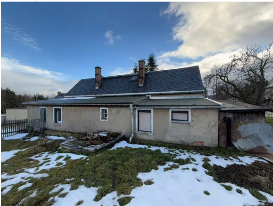
Wohnhaus, Westseite mit eingeschossigem Anbau
