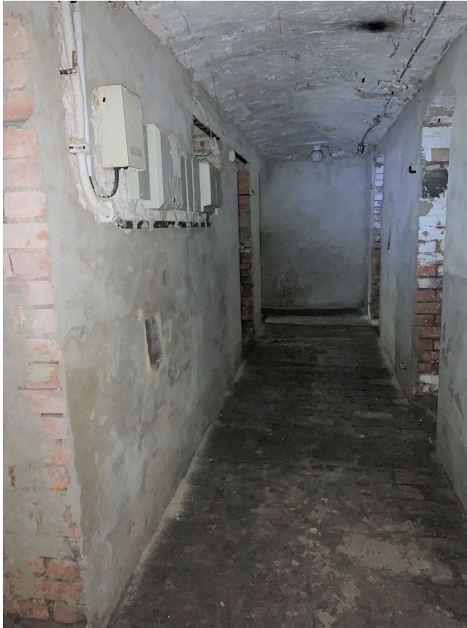
Abb. 11 Kellergeschoss, Teilansicht Kellergang
