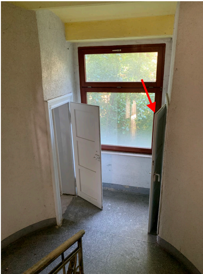
Abb. 04 Teilansicht Treppenhaus und Außenansicht von Abstellraum Nr. 4
