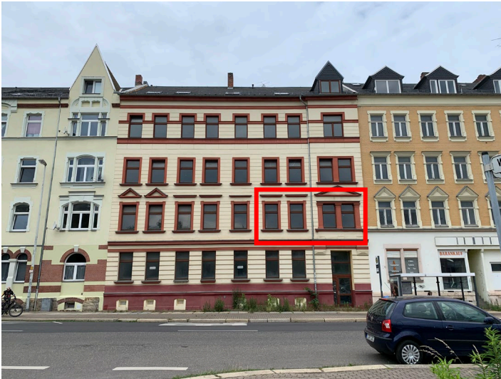
Abb. 01 Straßenansicht des Wohngebäudes und Lage der Wohnung Nr. 4 im 1. Obergeschoss, Osten
