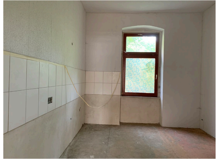
Abb. 08 Wohnung WE 4, Teilansicht der Küche
