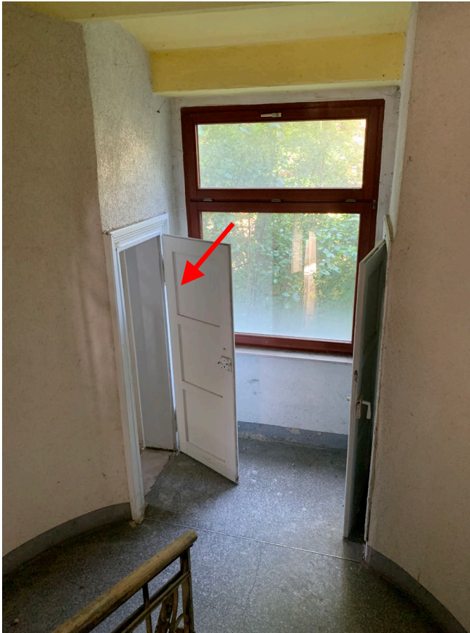
Abb. 04 Teilansicht Treppenhaus und Außenansicht von Abstellraum Nr. 3
