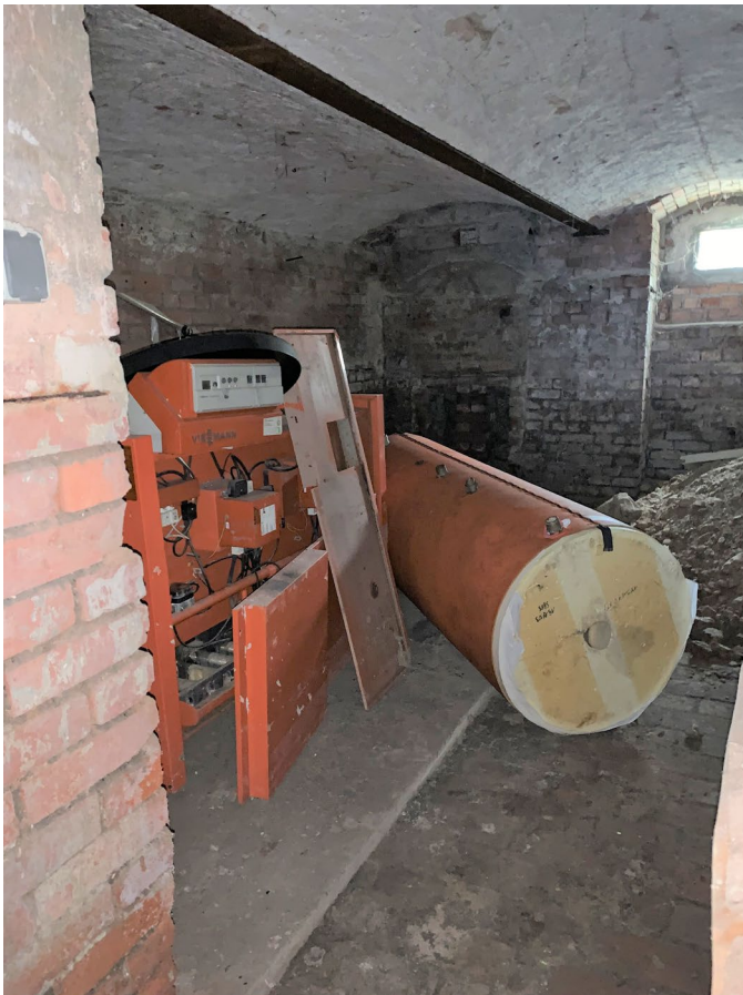
Abb. 12 Kellergeschoss, Ansicht Heizraum mit ehemaliger Gasheizungsanlage
