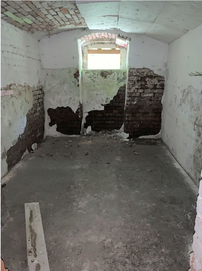
Abb. 11 Kellergeschoss, Ansicht Kellerraum, ohne Zuordnung
