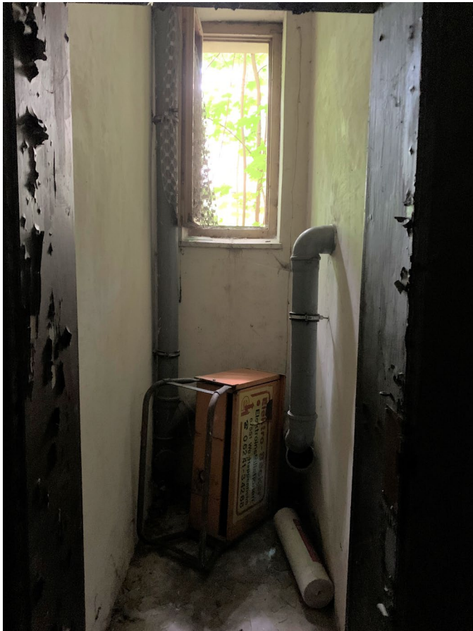
Abb. 08 Ansicht Abstellraum im Treppenhaus Nr. 2
